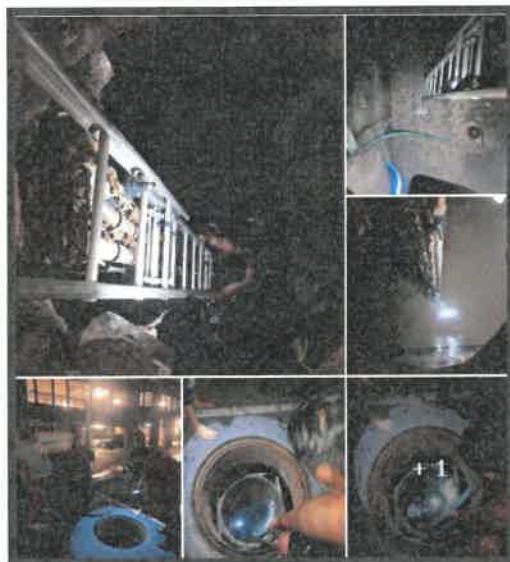
ตัดไข่มัน และสูบลูบตะกอนระบบบำบัดน้ำเสีย
