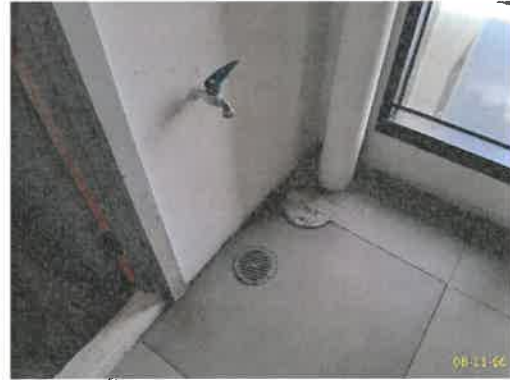
ภาพที่ 2.2-23 ตะแกรงครอบท่อระบายน้ำโครงการ
