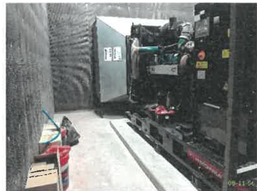
ช่องว่างระหว่างเครื่องกำเนิดไฟฟ้าสำรองกับผนังกันเสียง
