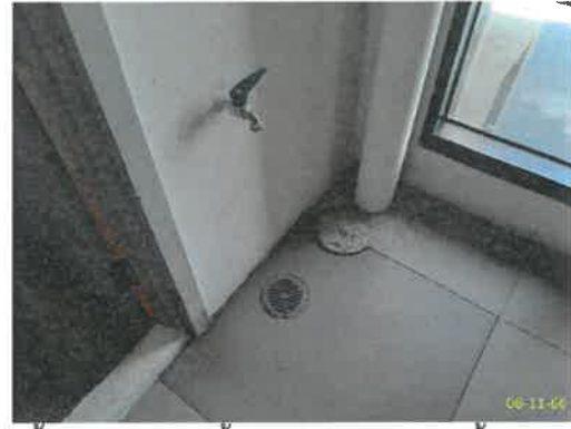
ก๊อกน้ำ และรูระบายน้ำ ห้องพักขยะประจำชั้น แบบที่ 1
