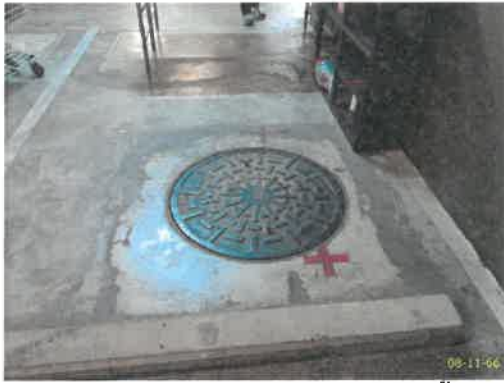
ฝาลังเก็บน้ำสำรองเพื่อการดับเพลิง ชั้นใต้ดิน
