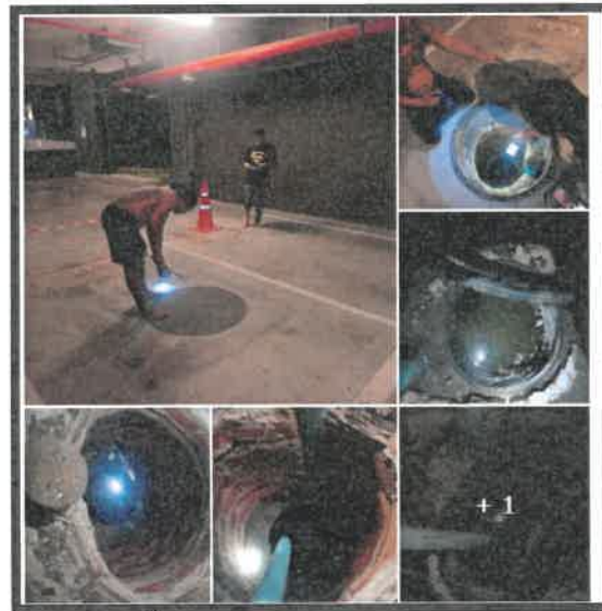
ตัดไข่มัน และสูบลูบตะกอนระบบบำบัดน้ำเสีย
